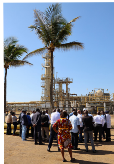
Foto: Visita da comitiva às instalações da Base Logística de Malongo.
